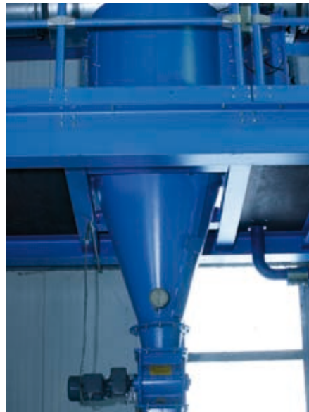
Totalabscheider-Taschenfilter mit 4,20 m 2 Filterfläche für eine stationäre Staubsauganlage
